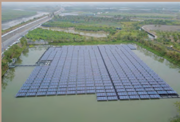
▲ 屏東大武丁滯洪池水面型太陽光電系統，利用水下錨定技術固定浮台。
