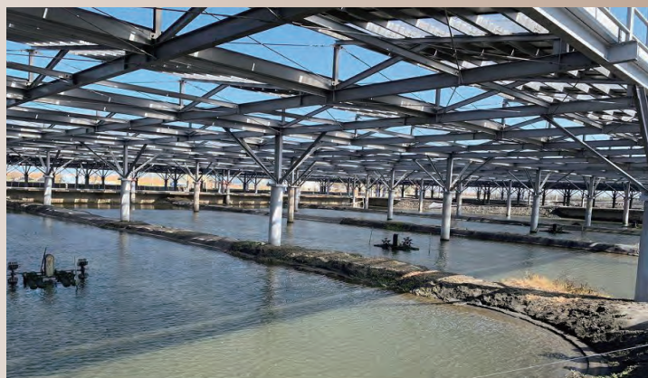
▲ 漁電共生案例，立柱位置盡量設置於埕堤上，減少魚塭內的落柱量。
