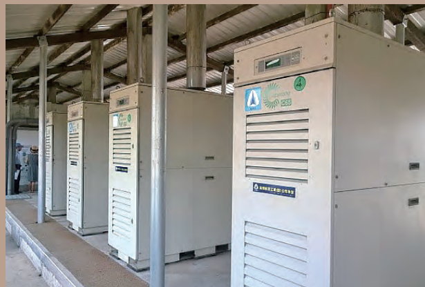
▲ 沼氣發電系統設置（漢寶畜牧場）
